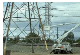
Tower 250: Recoiling of OPGW
